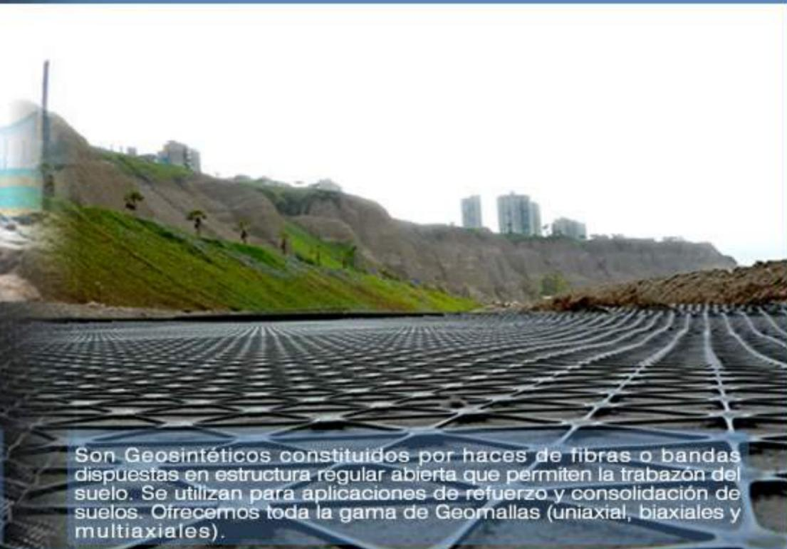
Son Geosintéticos constituidos por haces de fibras o bandas dispuestas en estructura regular abierta que permiten la trabazón del suelo. Se utilizan para aplicaciones de refuerzo y consolidación de suelos. Ofrecemos toda la gama de Geomallas (uniaxial, biaxiales y multiaxiales).
