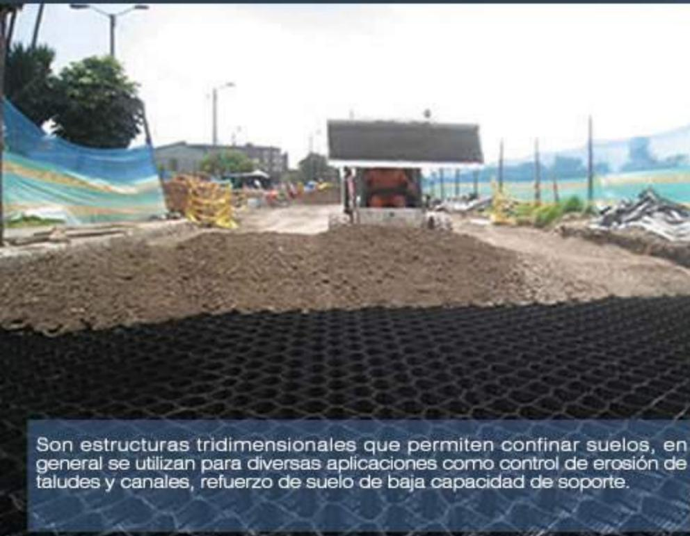
Son estructuras tridimensionales que permiten confinar suelos, en general se utilizan para diversas aplicaciones como control de erosión de taludes y canales, refuerzo de suelo de baja capacidad de soporte.
