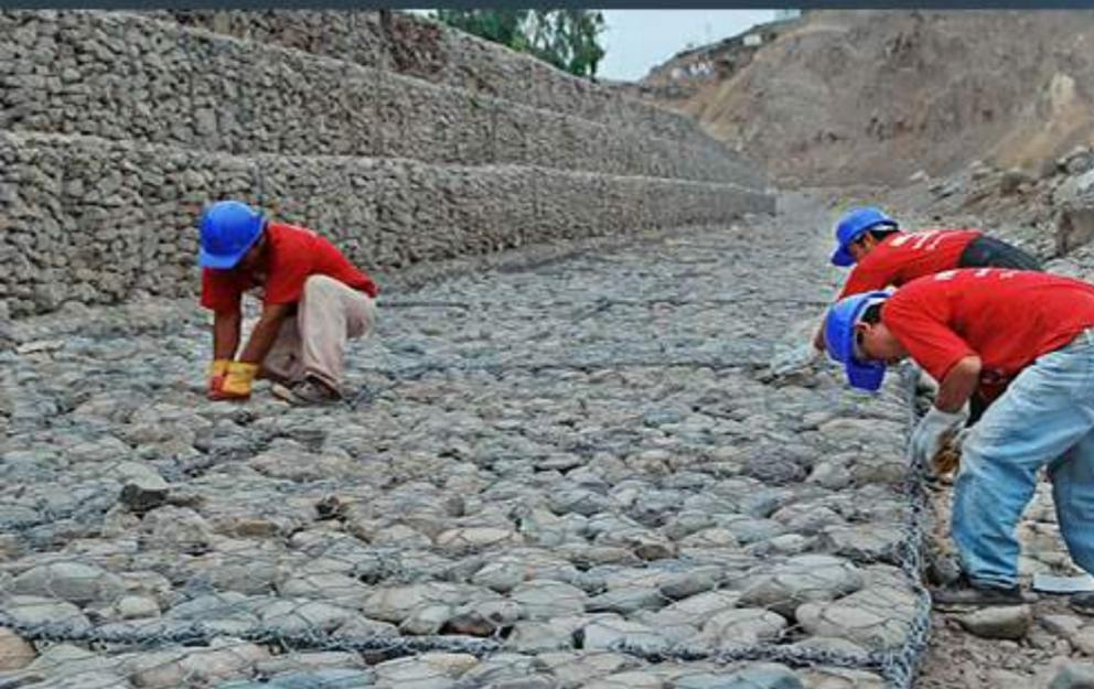
Ofrecemos la línea de gaviones confeccionados en malla hexagonal a doble torsión, en sus diferentes variedades como cajas, colchones, elementos para suelo reforzado (Terramesh) y redes de alta resistencia de acuerdo a las normas técnicas ASTM A-856/856M, ASTM A641-98, ASTM A 975-97.
